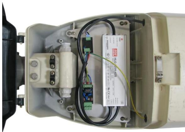
Fig. 5 Montaje del Módulo de alimentación ILUZ252.Q
