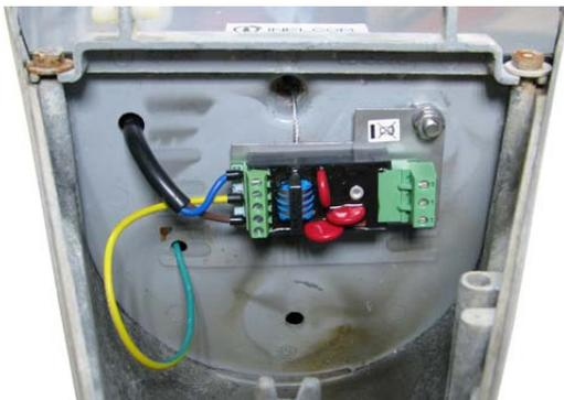
Fig. 7 Conexión del cable de tierra y del cable de alimentación al módulo de protección
