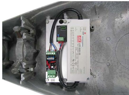
Fig. 6 Detalle de montaje del Módulo de alimentación en luminaria G.E. M-250R.
