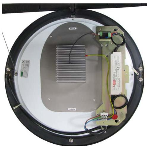
Fig. 5 Montaje del módulo de alimentación ILUZ252.H sobre la luminaria
