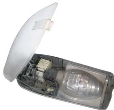
Fig. 2 Módulo óptico y equipo de alimentación originales
