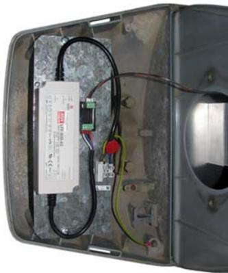
Fig. 5 Montaje del módulo de alimentación ILUZ211
